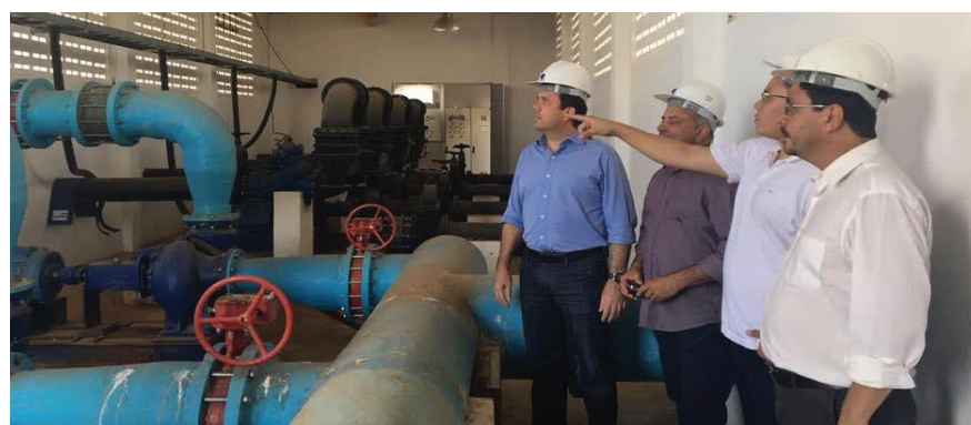
Adutora do Alto Oeste abastecerá 26 municípios, alcançando mais de 208 mil famílias com água de qualidade
